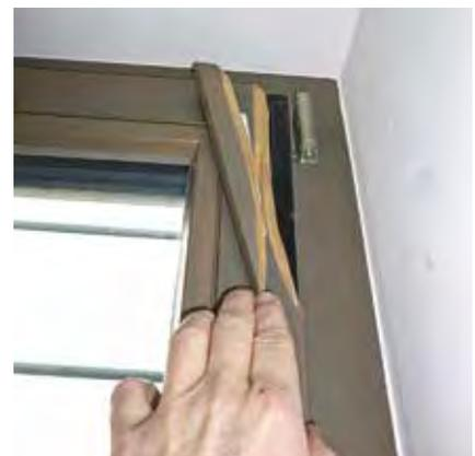
**Foto 2: Beschädigung eines Flügelrahmens aus Holz infolge „Leibungsschlag“**
