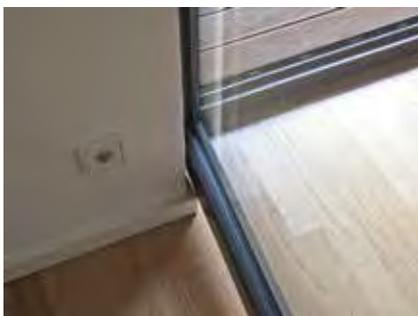
**Foto 4: Anschlagen eines Flügelrahmens an einer Fußleiste**
