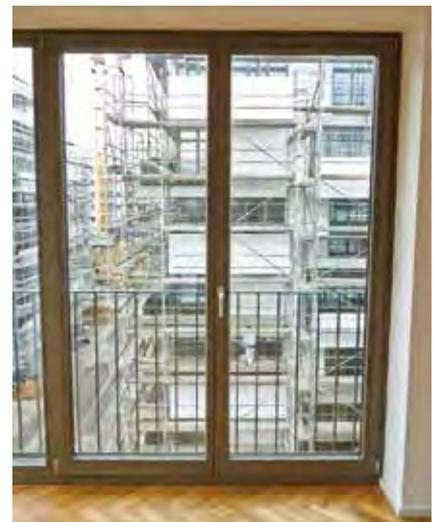
**Foto 1: Fensterelement mit großformatigem Öffnungsflügel unmittelbar angrenzend an eine Leibung**
