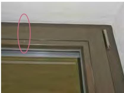
**Foto 3: Oberflächenbeschädigung am Flügelrahmen durch wiederkehrendes Anschlagen an der Leibung**
