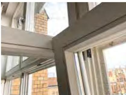
**Foto 5: Anschlagen eines Flügelrahmens an einem benachbarten, gekippten Flügel**
